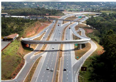
Figura 4: Vetor Norte: Obras viárias
